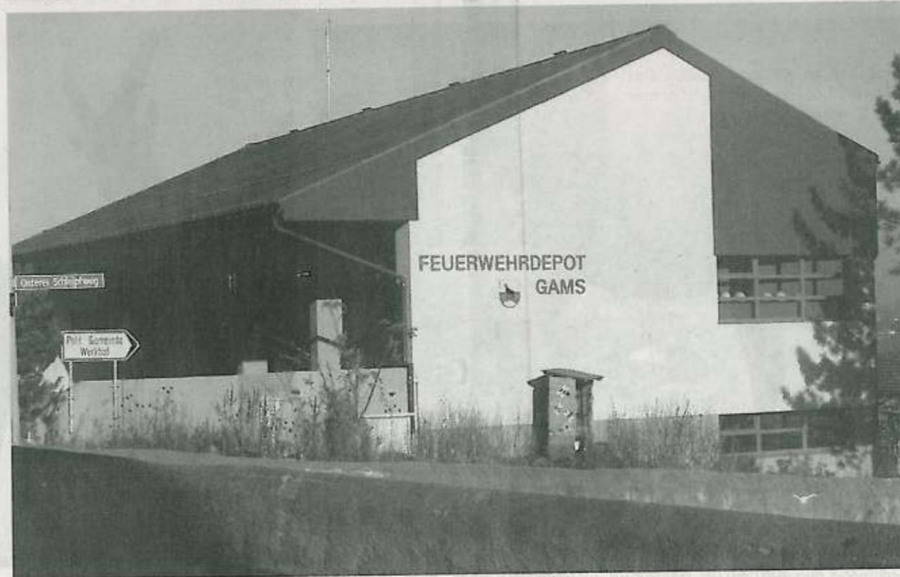
Umfassend saniert: Die Fassaden des Feuerwehrdepots und des Werkhofes «Hueb».
